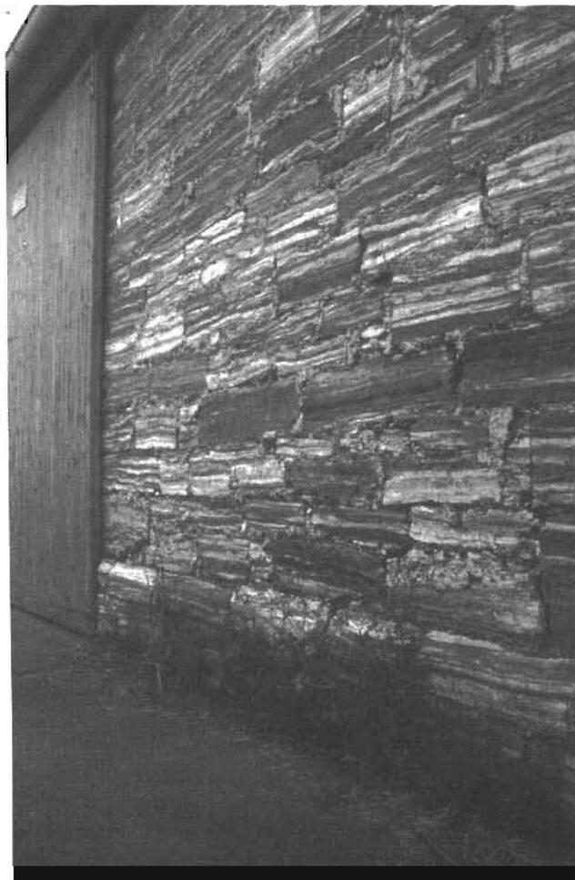
Abb. 1: Gipsmauerwerk an einer alten Scheune bei Bad Windsheim.
